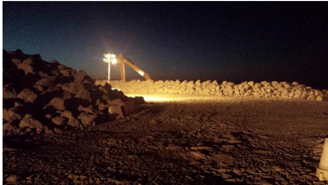
Éclairages sur le chantier du futur échangeur de La Possession (AO Ravine Lafleur)
