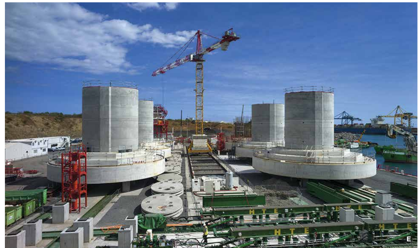
D Les têtes de piles les plus lourdes pèsent jusqu'à 2 000 t.
