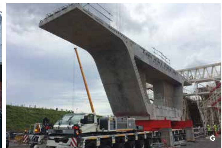
G Les voussoirs sont acheminés depuis l'aire de stockage jusqu'à leur lieu de pose sur des fardiers munis de 218 roues !
